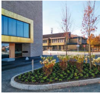
Eine bepflanzte »Insel« klärt die Verkehrsflächen in Zusammenhang mit der Ein- und Ausfahrt der Hotelgarage.
